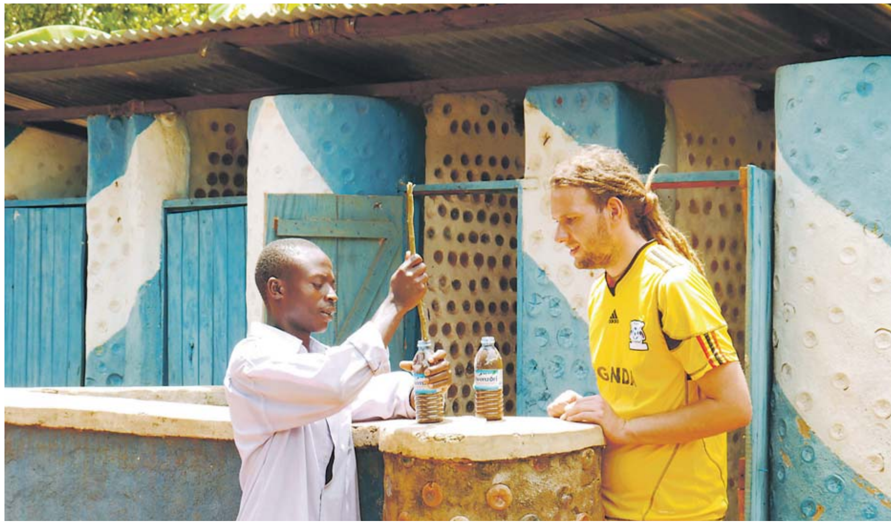
Wie Ziegelsteine Vorbild für das Projekt des Berliners Etienne Salborn (r.) ist ein Toilettenhäuschen in Ugandas Kayunga District. Die Plastikflaschen werden mit Lehm gefüllt
